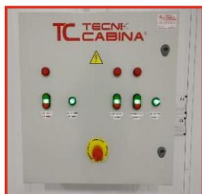
Armario eléctrico con protección de motores, iluminación y señalización
