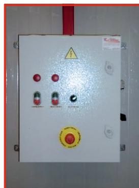
Armario eléctrico con protección de motores, iluminación y señalización
